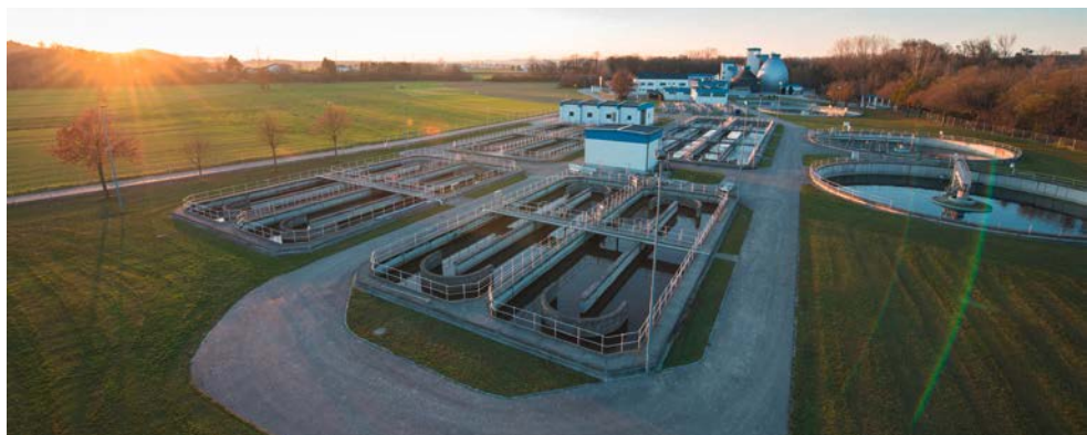
Luftbild Kläranlage Amstetten Belebungsbecken und Nachklärbecken
