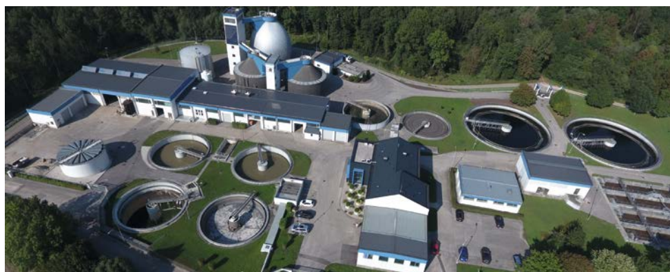
Luftbild Kläranlage Amstetten mit Faultürmen im Hintergrund
